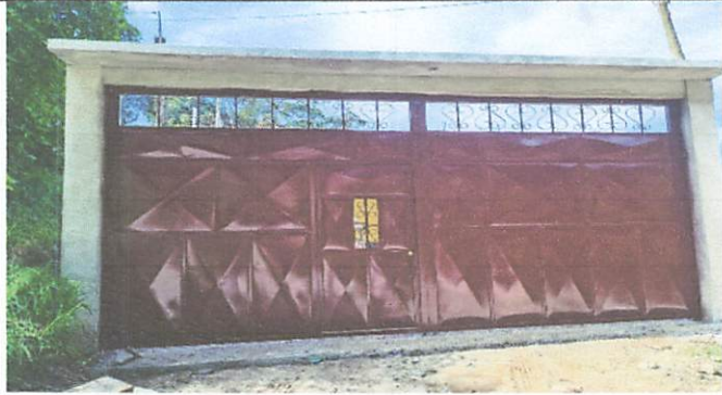
Foto1: Colocación de nuevo portón del instituto.
