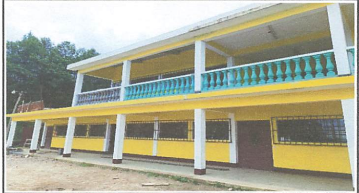
Foto 2: Colocación de muro perimetral.
