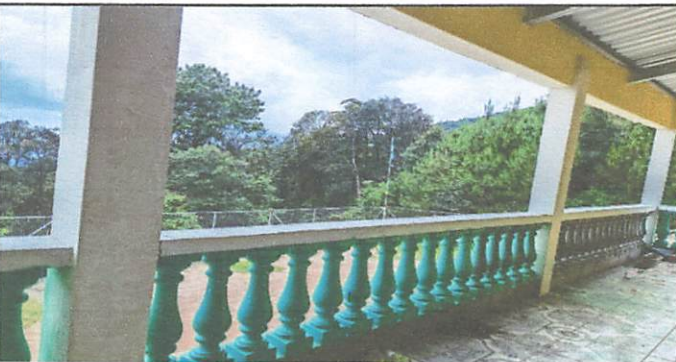
Foto 5: Colocación de muro perimetral de seguridad de segundo nivel.
