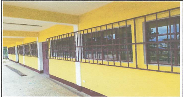
Foto 4: Colocación de balcones en las aulas de primer nivel.
