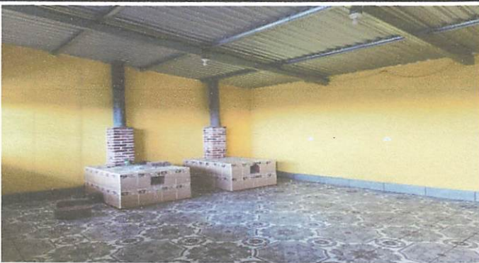
Foto 3: Colocación de piso cerámico interior de la cocina.
