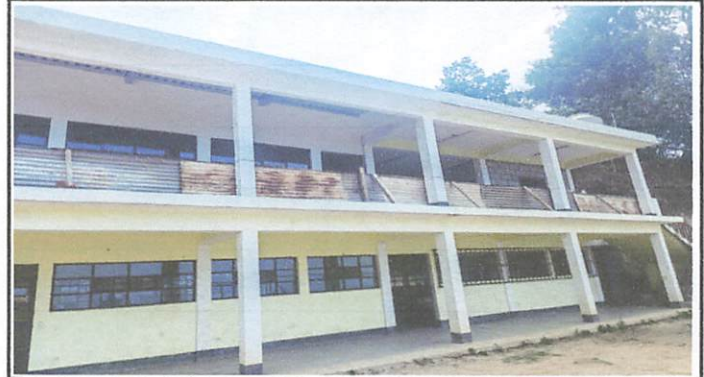
Foto 2: Colocación de muro perimetral segundo nivel.
