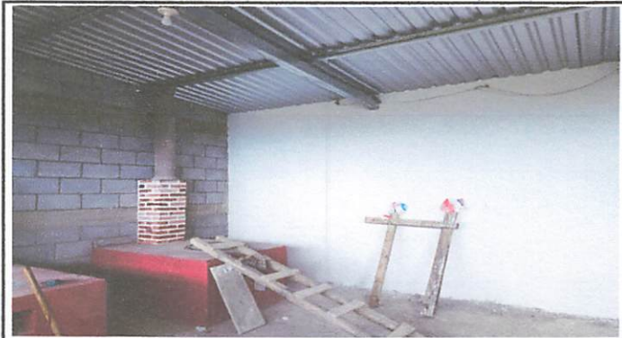
Foto 3: Colocación de cernido y piso cerámico.
