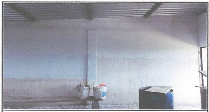
Foto 6: Cernido de paredes de la cocina.
