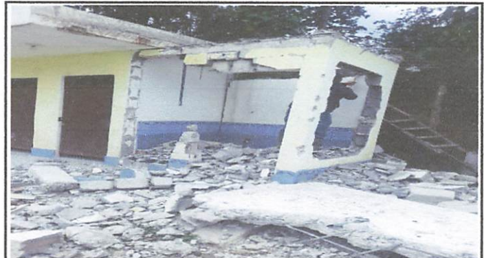
Foto 4: Demolición del mingitorio para nuevo levantado.
