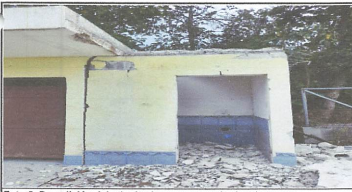
Foto 5: Demolición del mingitorio para engancharlo a la terraza.
