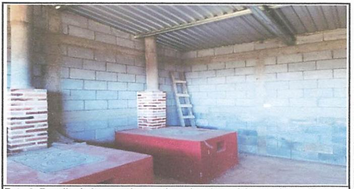
Foto 6: Repello de las paredes y colocación de azulejo para los pollos.
