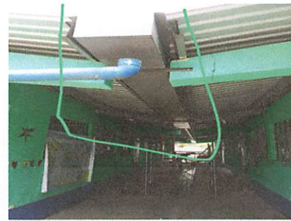
FOTO No. 4 Cambio de canales en 26 metros del corredor
