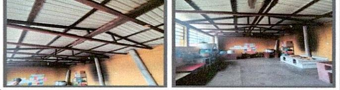
**Foto 2: Cambio de estructura del techo de la cocina, de madera a metal y remodelación eléctrica.**
