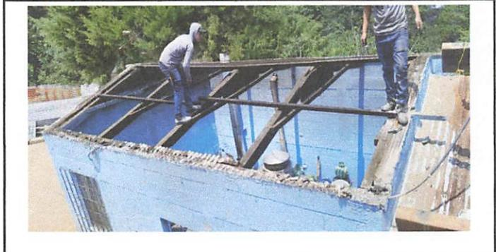
Foto 2: Reparación y cambio de techado de la cocina.
