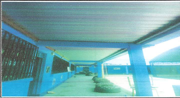
Foto 1: Techo cambiado con lámina troquelada calibre 24
