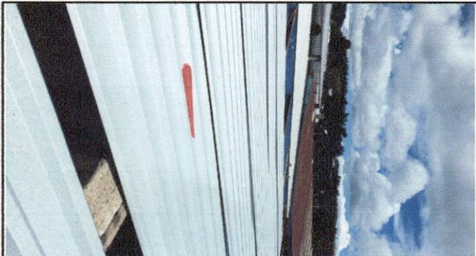
Foto 3: Colocación de lámina troquelada calibre 24
