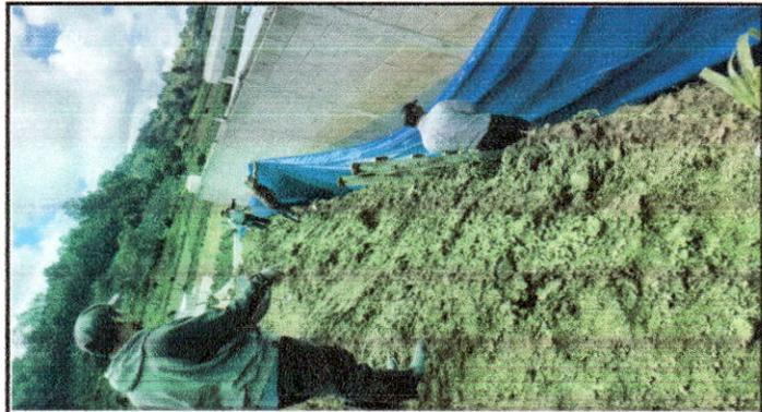
Foto 10: Colocación de nylon para protección de pared
