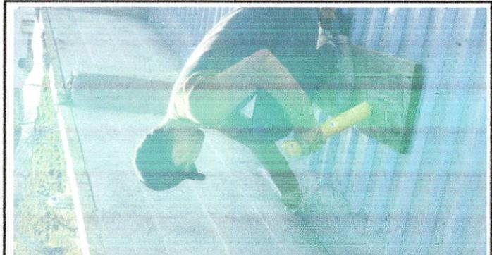
Foto 12: colocación de silicon para evitar filtración de aguas pluviales
