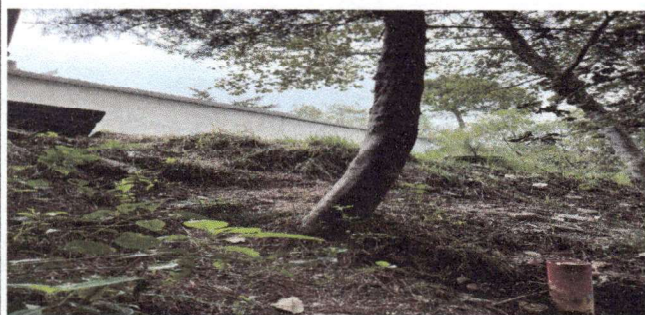
Foto 1: Levantado de talud
