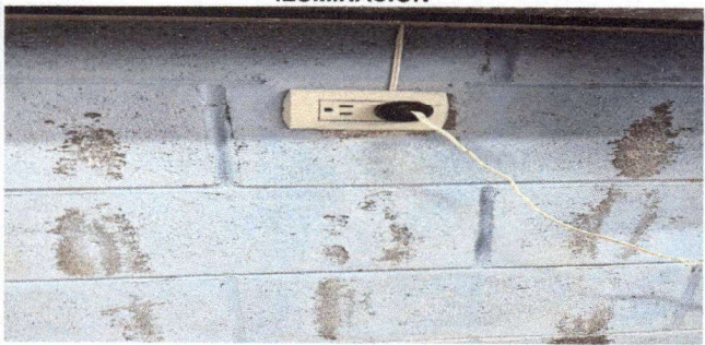
foto 5: Ampliacion de sistema electrica
