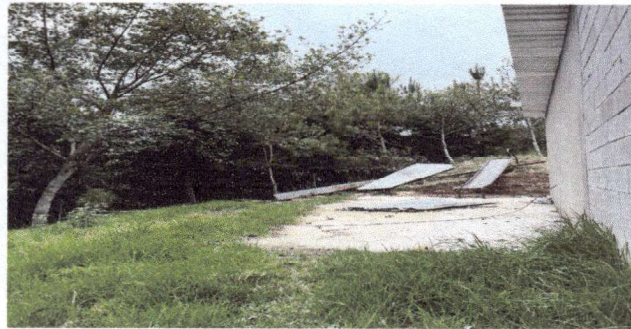
Foto 2: Levantado de talud
