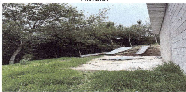
Foto 6 : pintura en muros interior y exterior
