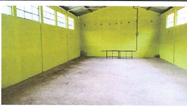
Foto 3: Colocación de piso ceramico en salon de usos multiples
