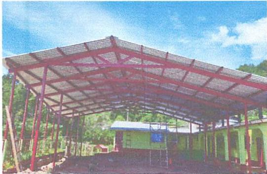
FOTO: 1 TECHADO DE PILA Y CORREDOR
