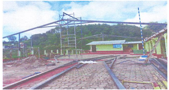
FOTO: 1 TECHADO DE PILA Y CORREDOR
