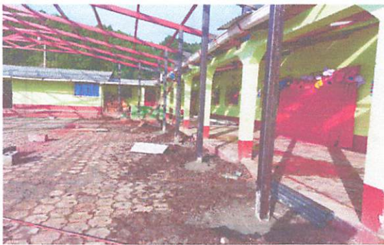
FOTO: 1 TECHADO DE PILA Y CORREDOR
