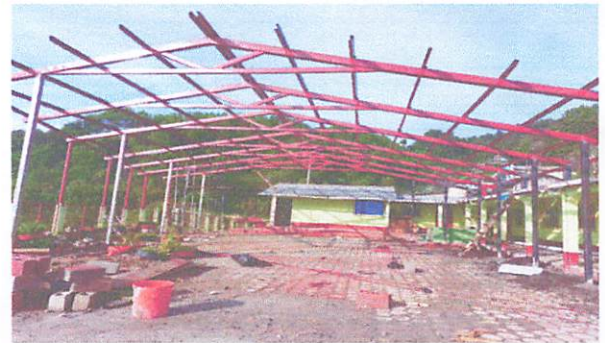
FOTO: 1 TECHADO DE PILA Y CORREDOR
