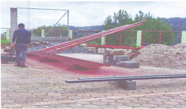
FOTO: 1 TECHADO DE PILA Y CORREDOR
