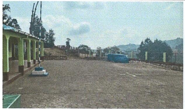
FOTO: 1 TECHADO DE PILA Y CORREDOR
