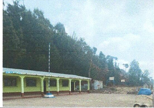
FOTO: 1 TECHADO DE PILA Y CORREDOR
