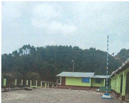
FOTO: 1 TECHADO DE PILA Y CORREDOR
