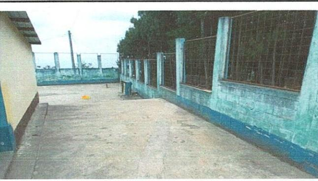
Foto 10: Pintura en paredes de circulación, se ve deteriorado y viejo
