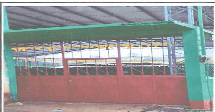
Foto 6: reparación de portones
