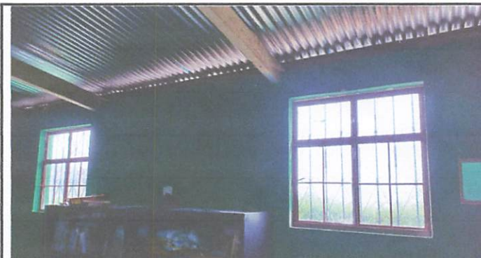
Foto 4: Reparación de ventanas
