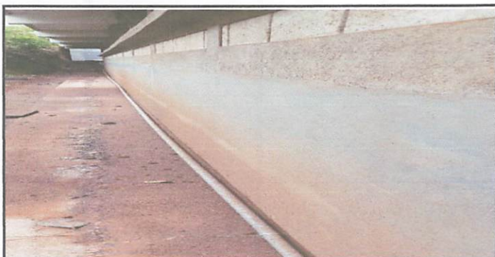
Foto 5: repello e impervialización de salones y tubería de agua potable.
