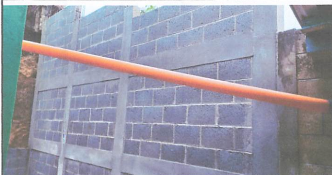
Foto 1: muro de contención
