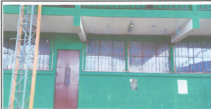
Foto 3: balcones en ventanas
