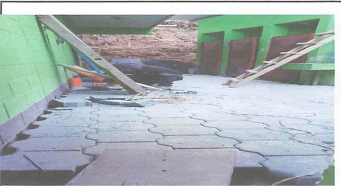
Foto 4: colocación de adoquín en área de servicios sanitarios
