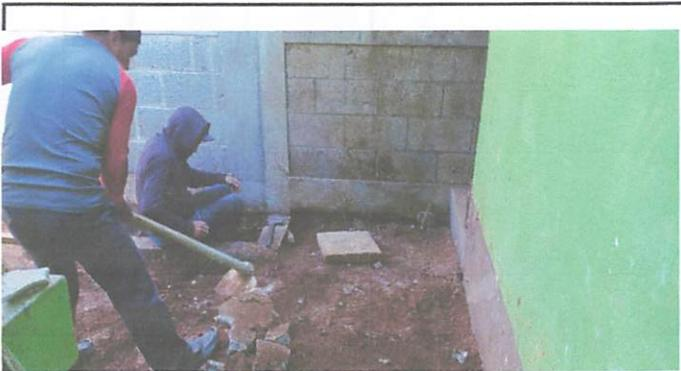
Foto 3: construcción de caja de captación de drenaje y lavamanos
