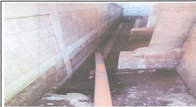
Foto 1: cambio de tubería a fosa séptica
