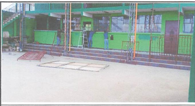
Foto 6: colocación de barandas a ventanas
