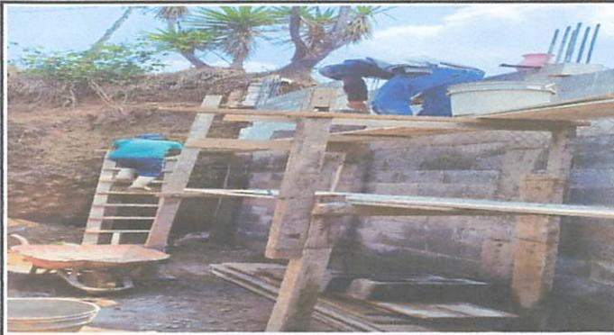
Foto 2: construcción de muro de contención
