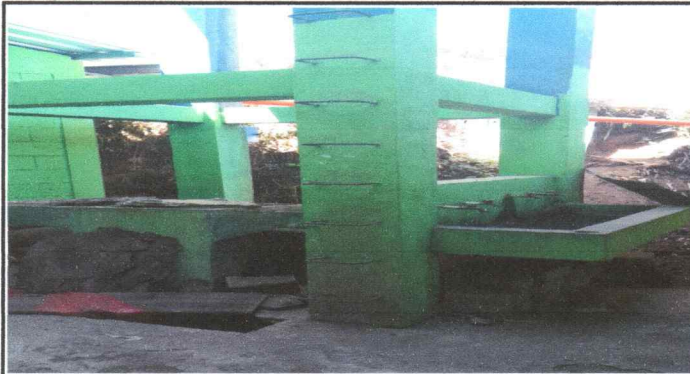
Foto 3: construccion de caja de captación de drenaje y lavamanos
