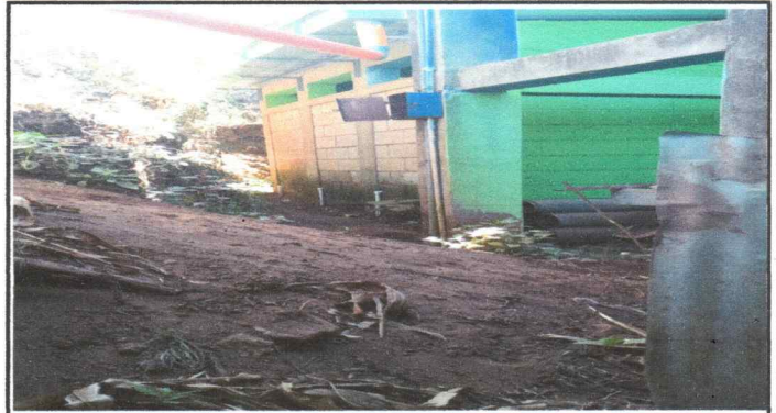
Foto 2: Linea de drenaje de sanitarios y muro de contención
