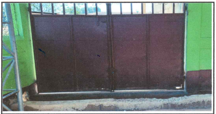
Foto 6: Reparación de portones en estado deteriorado
