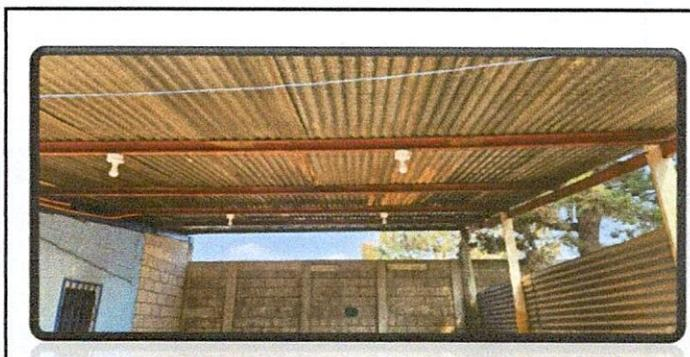
AREA No. 4 FABRICACIÓN, COLOCACIÓN DE TECHO DE ESTRUCTURA DE METAL Y LAMINA TROQUELADA PARA AREA DE AMPLIACIÓN DE COCINA
