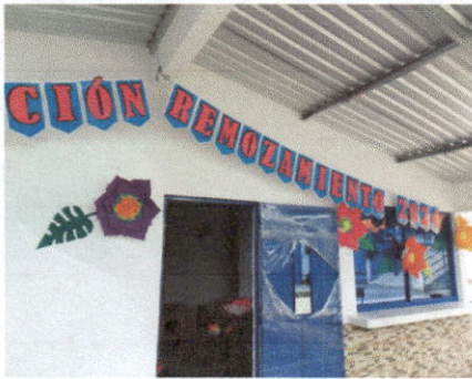
FOTO 3. MEJORAMIENTO DE COCINA.
