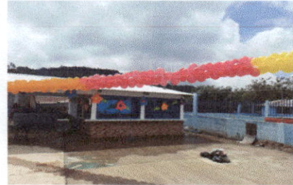
FOTO 2. MEJORAMIENTO DE COCINA.
