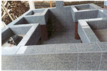
FOTO 5. MEJORAMIENTO DE PILA.
