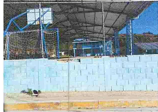
FOTO 6. MEJORAMIENTO DE MURO PERIMETRAL.
