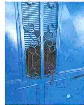
FOTO 4. MEJORAMIENTO DE COCINA.
