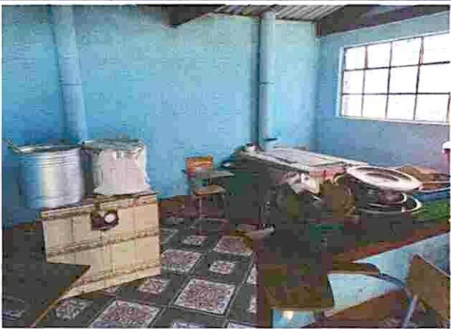
FOTO 3. MEJORAMIENTO DE COCINA.
