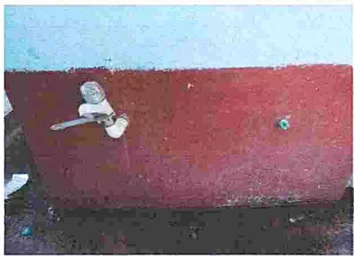
FOTO 1. MEJORAMIENTO DE DEPÓSITO DE AGUA.
