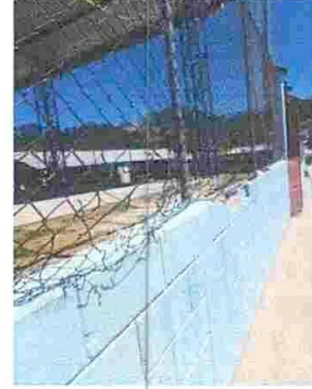
FOTO 8. MEJORAMIENTO DE MURO PERIMETRAL
