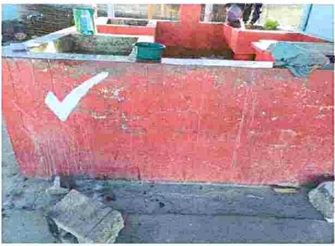
FOTO 5. MEJORAMIENTO DE PILA.
