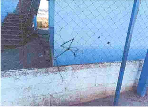
FOTO 7. MEJORAMIENTO DE MURO PERIMETRAL.
