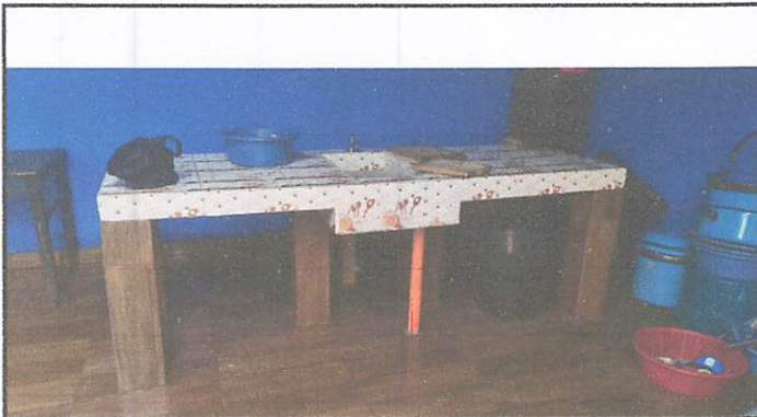
construccion del nuevo lava trastos
