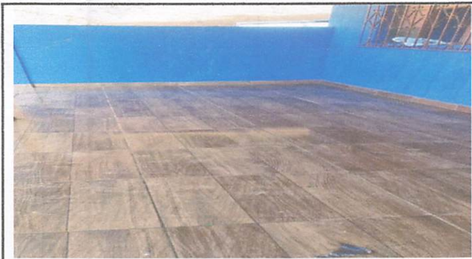
Piso con azulejo terminado.
