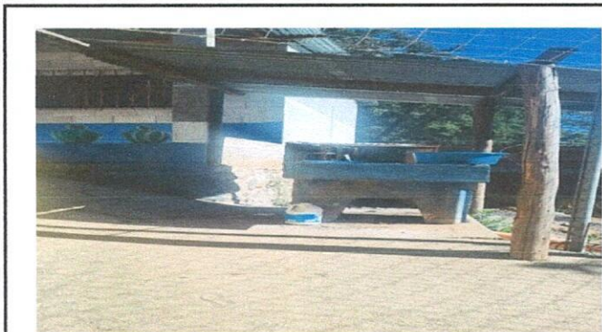
la pila se encuentra en malas condiciones
