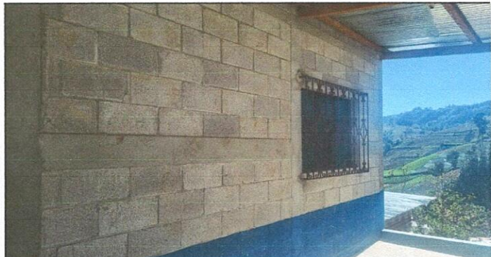
las paredes de la cocina se encuentran en malas condiciones, se penso en un repello de monocapa
