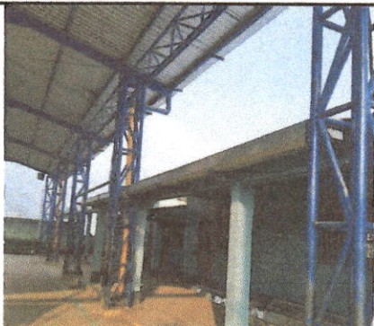
Foto 5: Establecimiento No. 2 Canales y bajadas de agua Pluvial
