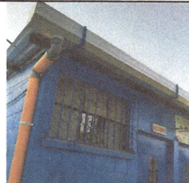
Foto 4: Canales y bajadas de agua pluvial. Establecimiento No. 2
