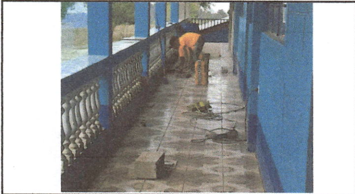
Foto 1: Establecimiento No. 1 colocación de piso en pasillo de modulo 1, 2, 3 y 4
