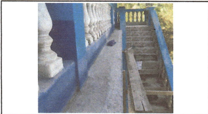
Foto 3: Establecimiento No. 1 Remodelación de voladizo
