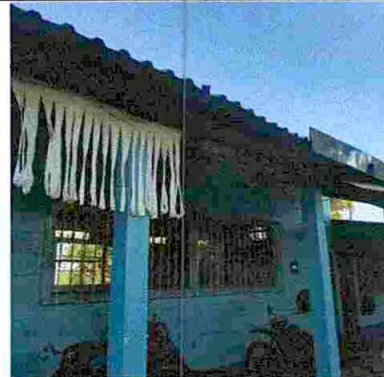
Foto 4: Canales y bajadas de agua pluvial. Establecimiento No. 2
