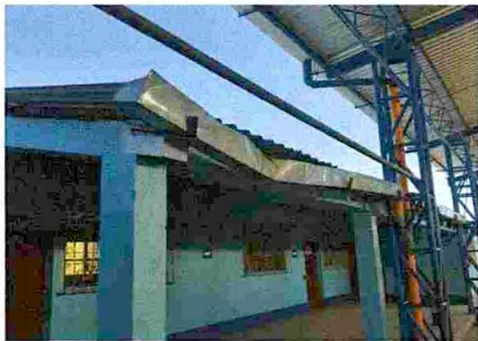
Foto 5: Establecimiento No. 2 Canales y bajadas de agua Pluvial
