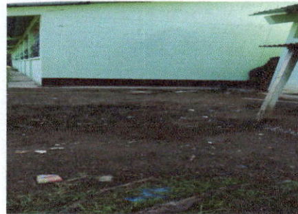
Cambio de cisternas de drenajes
