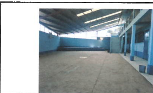
Foto 12: VISTA LATERAL DEL AREA A REMOZAR
