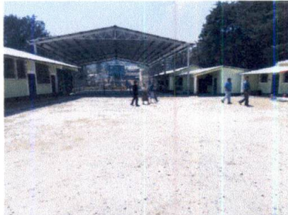
Foto 9: AREA FRONTAL DONDE SE FABRICARA EL PISO TORTA DE CONCRETO
