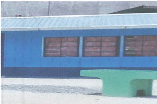
Cambio de pila de concreto de dos alas
