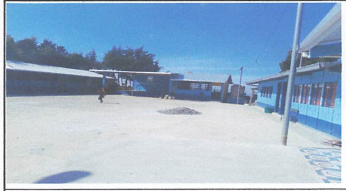
Finalizacion de Remozamiento
