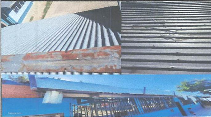
Necesario remozamiento de estructura metalica del techo y cambio de cubierta y cambio de canales
