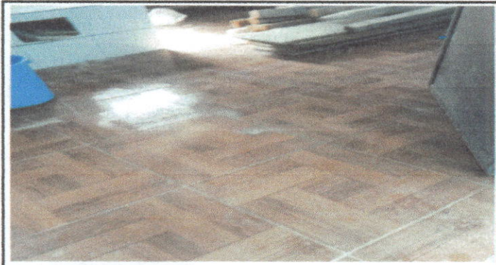
FOTO 1: POSTERIOR DE LA COLOCACION DE PISO CERAMICO DE COCINA
