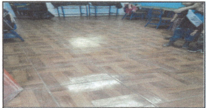
FOTO 6: POSTERIOR COLOCACION DE PISO CERAMICO EN EL AULA
