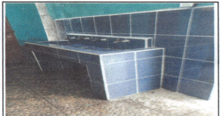
FOTO 4: POSTERIOR COLOCACION DE AZULEJOS AL LAVAMANO
