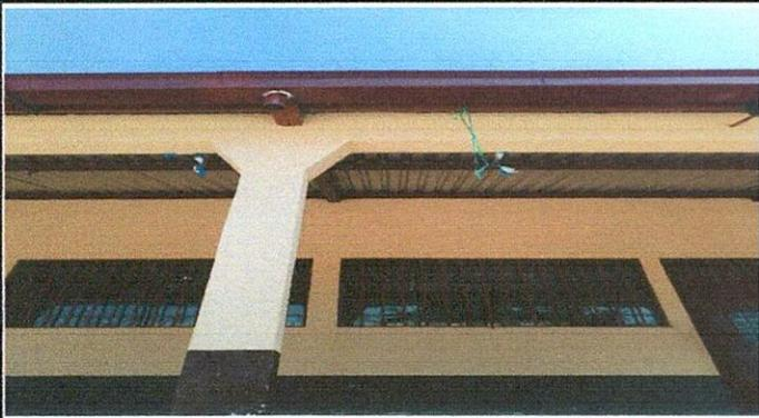
Foto 7: COLOCACION DE TUBO GABANIZADA PAR BAJADA DE AGUA
