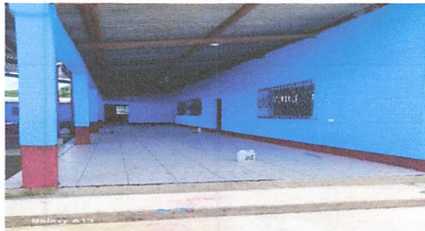
Foto1: Proyecto Terminado (corredor).
