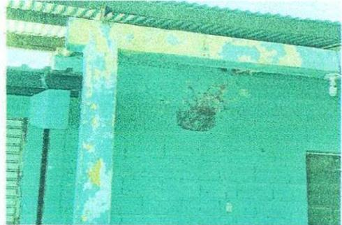
Foto 2: en la fotografía se puede observar que los muros y exteriores se deben pintar.
