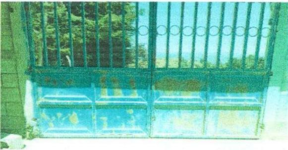
Foto 3: los portones deben tener un mantenimiento ya que se encuentran en muy mal estado.
