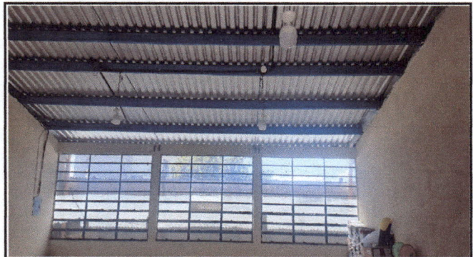
Foto 4: vista interior de una de las aulas que fue mejorado su sistema eléctrico.
