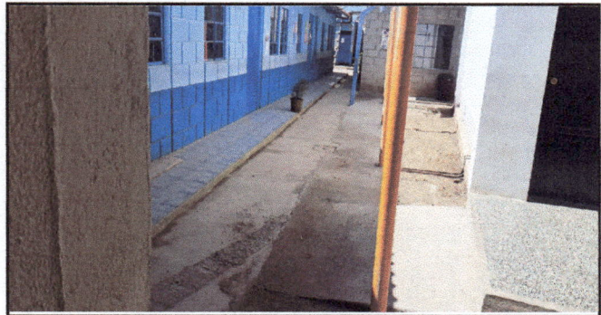
Foto 6: Vista frontal del pavimento ampliado del área de preprimaria.
