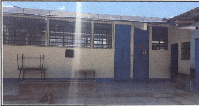
Foto 5: Vista frontal de las aulas que fueron remozadas.
