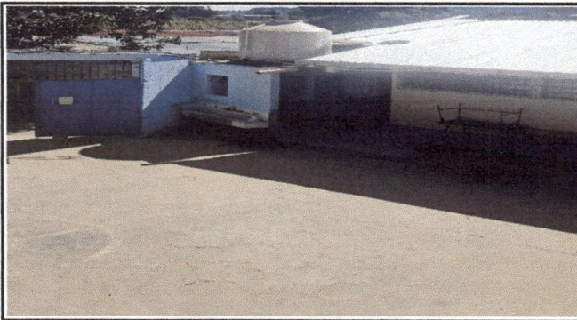
Foto 3: Vista de uno de los tinacos que se cambiaron.
