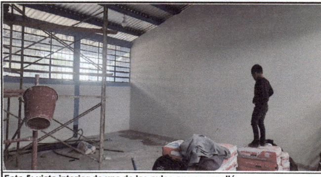
Foto 5: vista interior de una de las aulas que se repelló.
