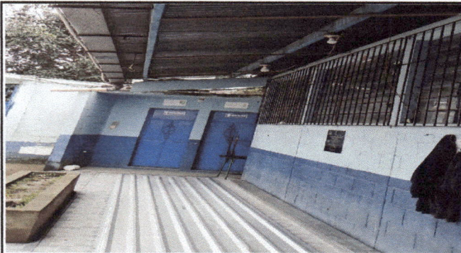
Foto 3: Vista frontal de las aulas que se les colocó su balcón.
