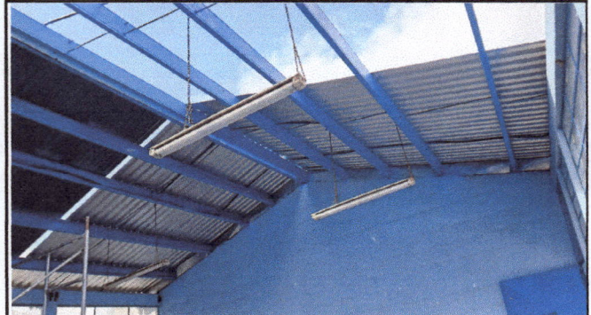
Foto 2: Foto interior de las aulas que se les cambió su techo.
