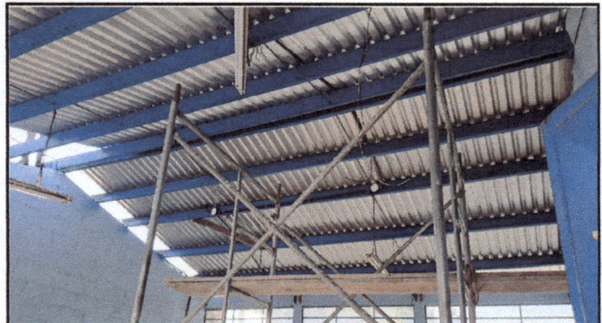
Foto 4: vista interior del aula que se le mejoró su instalación eléctrica.
