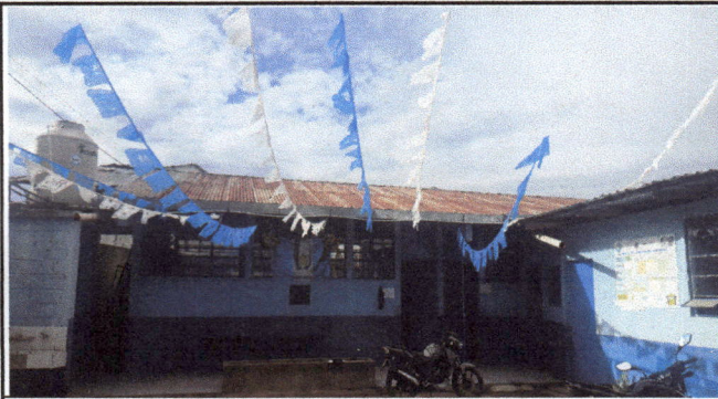
Foto 1: Vista frontal de las aulas que se van a remozar.
