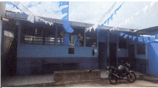
Foto 3: Vista frontal de las dos aulas que se van a repellar.
