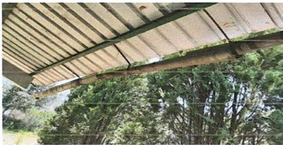
Foto 5: Canales de agua en mal estado cambio total, y cambio de instalaciones electricas en las afueras del aula
