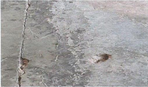
Foto1: piso de torta deteriorado dentro de las aulas y direccion.
