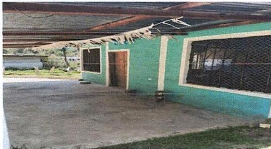
Foto 3: piso de torta dentro y corredor de cocina, ventanas con malla. Cambio de ventana y piso de la cocina.
