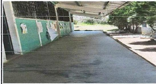
Foto 2: piso de torta corredor de aulas y direccion. Necesita cambio
