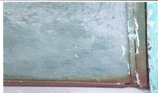
Foto 6: puerta de los baños deteriorados tanto el metal como las chapas, necesita cambio total. Necesita reparar algunas puertas y cambiar en otras.
