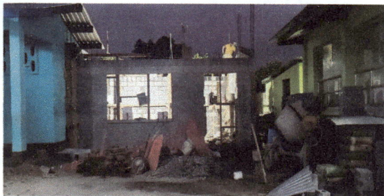
Foto 5: Inicio de armado de techado.
