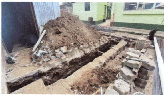
Foto 3: Base solida de construcción.
