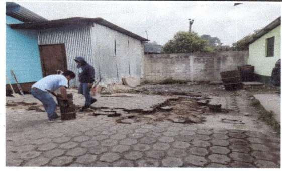
Foto 6: Habilitando el area para inicio de trabajos de ampliación de cocina.
