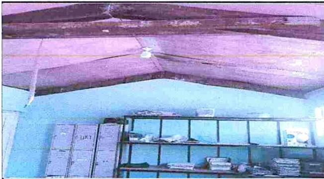
Foto 3: CAMBIAR EL CIELO FALSO
