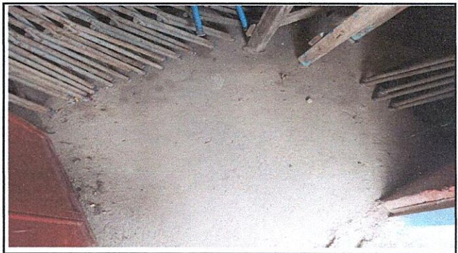
Foto 2: Sustitución de piso de torta de concreto por piso cerámico (suministro de piso cerámico)
