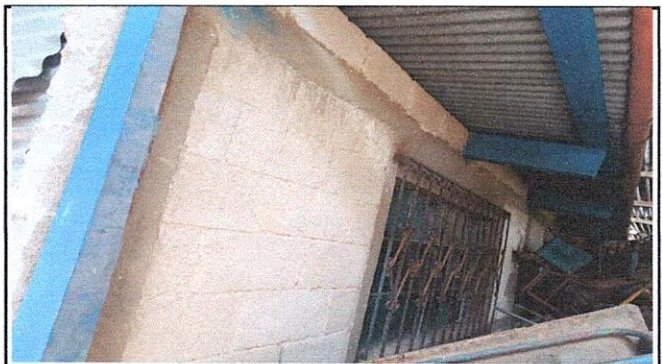
Foto 4: Cambio y colocación de balcones para ventanas.
