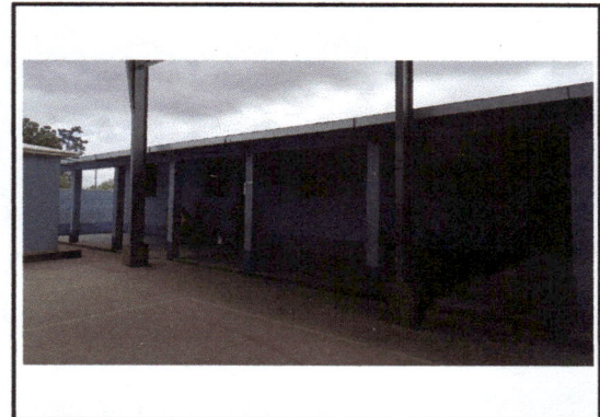
Foto 10: Colocación de canales y bajadas de agua.
