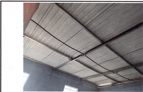
Foto 2: Colocación del alumbrado en estructura de metal y lámina.
