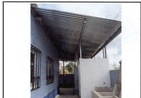
Foto 12: Sustitución de lámina en área de sanitarios.
