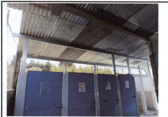
Foto 11: Colocación de estructura metálica de área de sanitarios.
