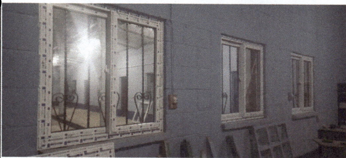
Foto 5: Colocado de ventanas de pvc
