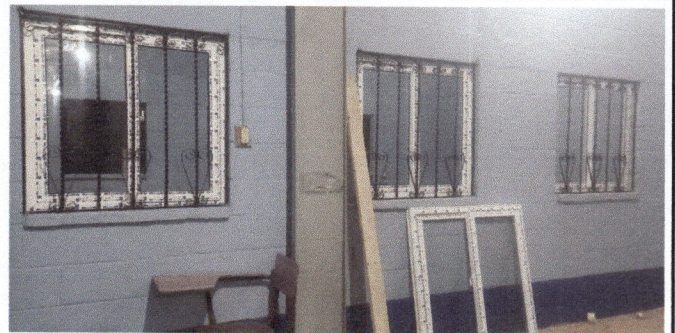
Foto 6: Balcones y ventanas culminados.
