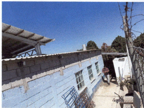
Foto 4: Finalización del levantamiento de pared, para mejorar la ventilación.
