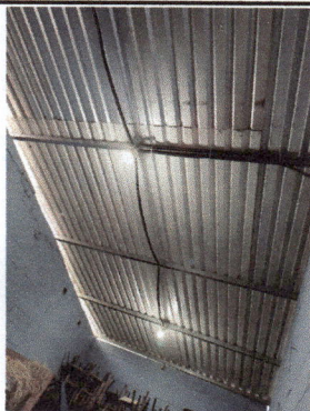
Foto 3: Colocado de lámina, estructura de metal y sistema eléctrico.
