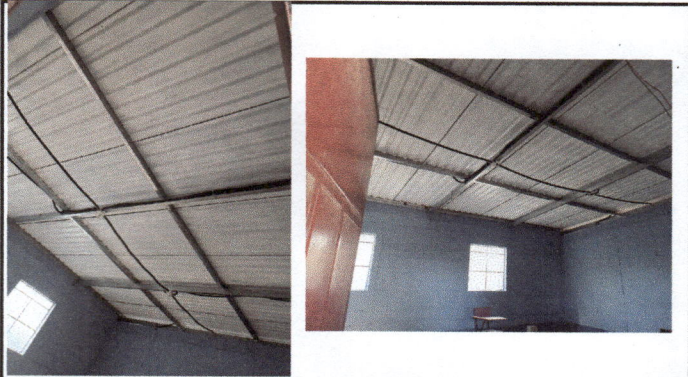
Foto1: Culminación del colocado de la estructura de metal en todos los salones.
