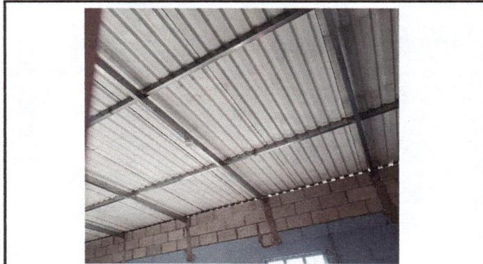
Foto 2: Levantamiento de block, estructura de metal y lámina.
