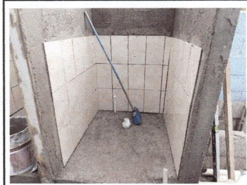
Foto 8: Sustitución de piso cerámico y azulejo en las paredes
