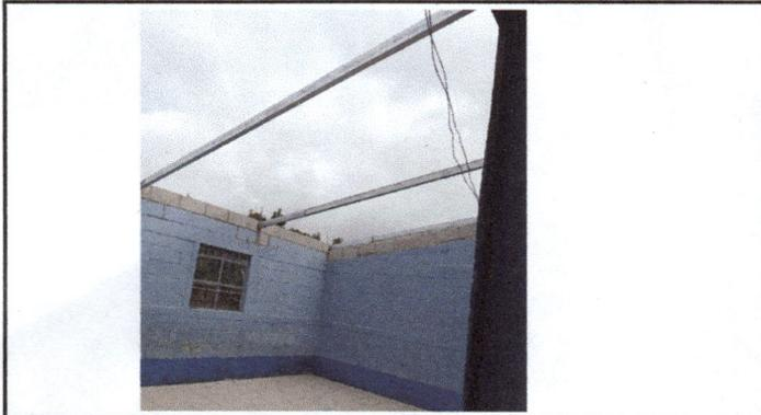
Foto 1: Colocado de block y estructura de metal.
