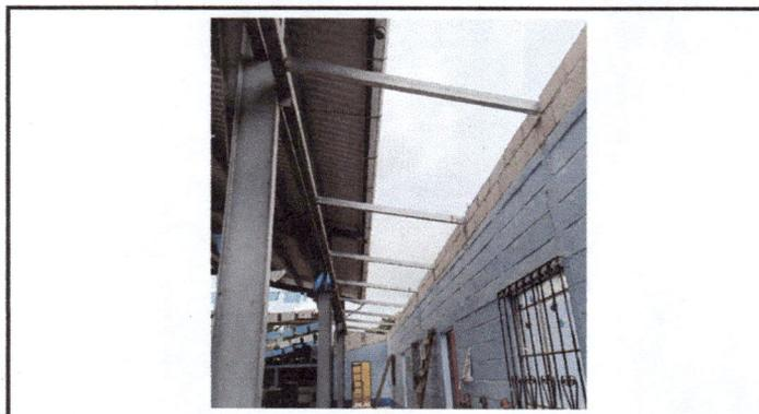
Foto 4: Colocado de filas de block en las paredes, para mejorar la ventilación
