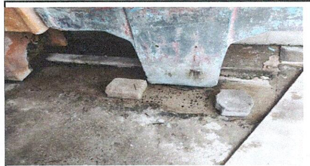
reparacion de torta de concreto
