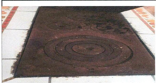
sustitucion de pancha
