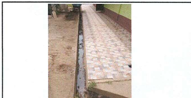
Foto 6: Colocación de acera y rejilla sobre la cuneta.
