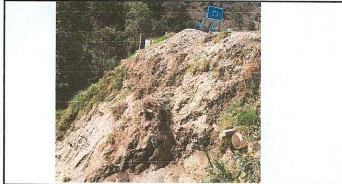
Foto 1: Primer tubo del sistema principal de aguas pluviales que necesita ser atendida.
