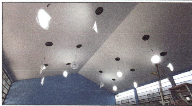
Foto 3: Aula de párvulos sección A, primera fase de sistema eléctrico, cielo falso y pintura.
