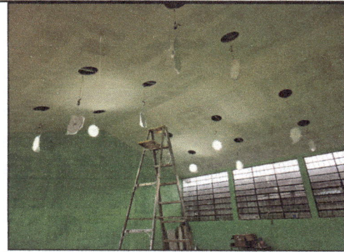
Foto 2: Aula de 6to. Grado sección A, colocación de cielo falso y sistema eléctrico.
