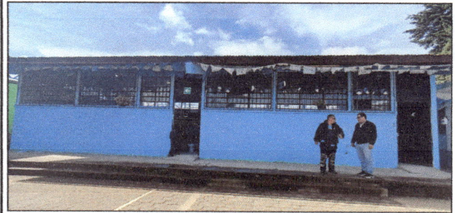
Foto 4: Fachada de los dos salones remozandose, con primera capa de pintura.
