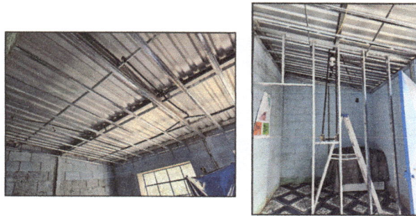
Foto 5: Interior de cocina, colocación de cielo falso.
