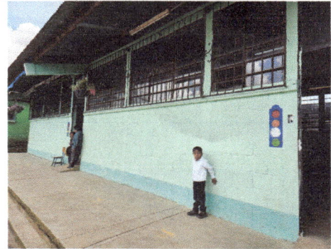
Foto 4: Fachada de los dos salones a remozar.
