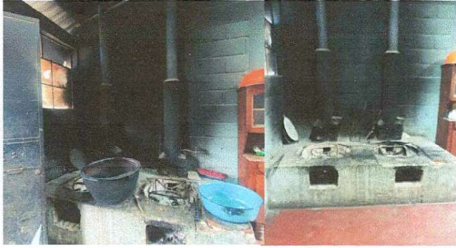
Foto 1: Remozamiento de polletones, en esta área se cocina la refacción con ollas mas grandes y pesada, por lo cual se necesita tener una chimenea grande para absorber mejor el humo, mejorar el espacio donde se sientan las ollas.
